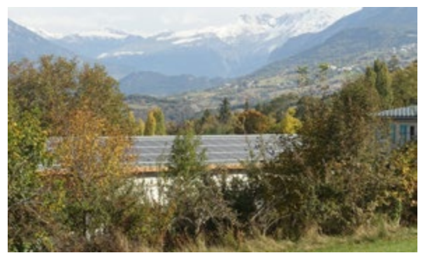
«La Baratonne» Salle des fêtes de Baratier
